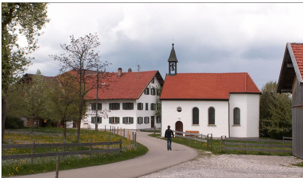
Abb. 6: markanter, historisch verfestigter Freibereich im Umfeld der Kapelle „Verklärung Christi“, © Denkmalliste Bayern 2021
