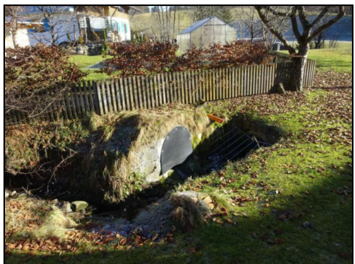
Abbildung 17: Einlauf Verrohrung West DN 1000
