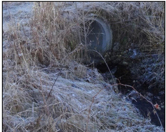
Abbildung 8: Durchlass DN 1500 östlicher Bach
